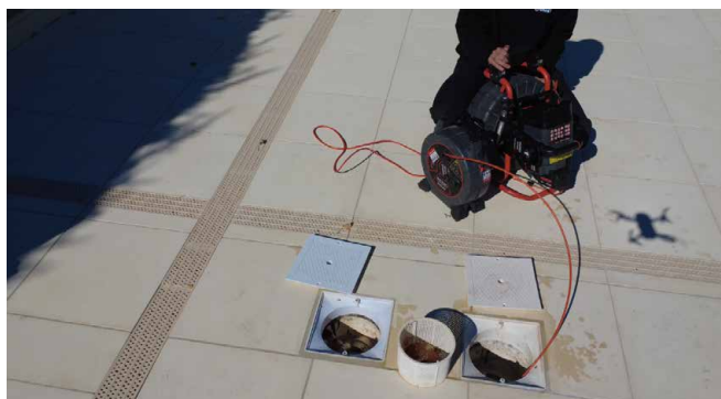
Inspection vidéo des canalisations de skimmers : RAS.
