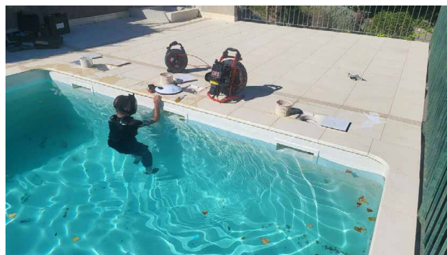
Inspection prise balais : RAS.
