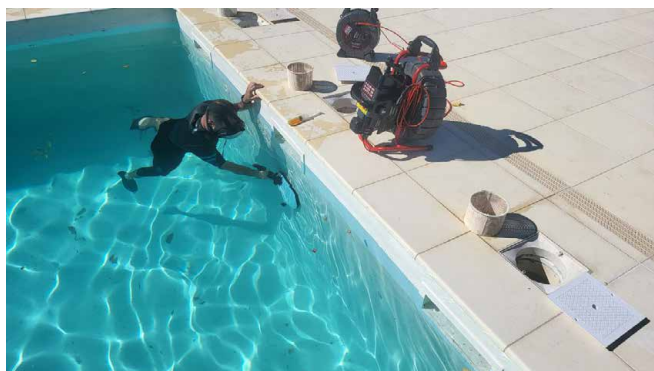
Test d'étanchéité de la pièces de scellement éclairage: RAS.
